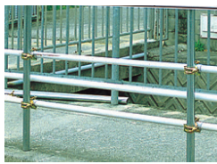
単管パイプの取付
