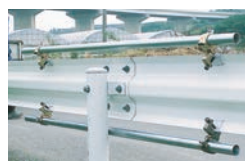
単管パイプの取付
