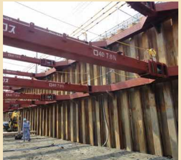
貯留槽新設工事
