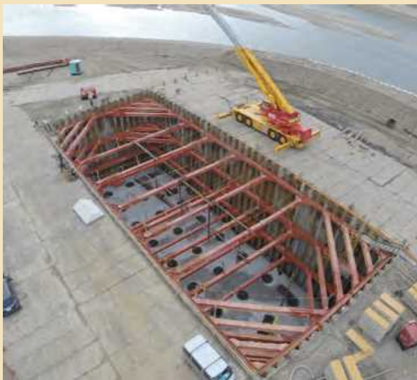
橋脚新設工事
