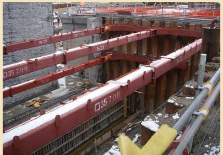
頭首工改修工事
