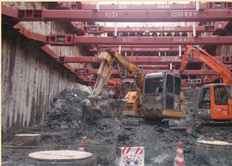
道路函渠工事
